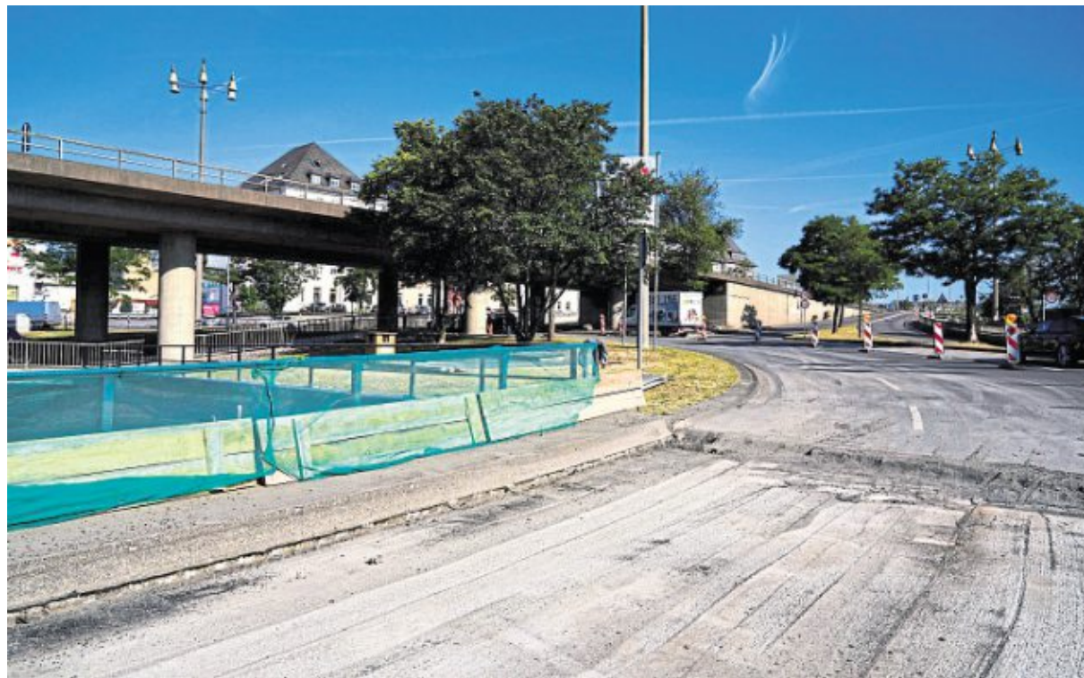
Die Arbeiten am Saarkreisel in Koblenz liegen im Zeitplan. Nach der Sperrung der innen liegenden Fahrspur ist im zweiten Bauabschnitt die außen liegende Fahrspur an der Reihe.
